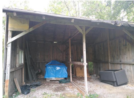
Abbildung 13: Hütte im Nordwesten des Plangebietes (Mühl 12.09.2023)
