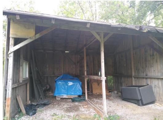
Abbildung 13: Hütte im Nordwesten des Plangebietes (Mühl 12.09.2023)
